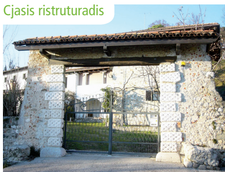
Un portâl ristrutturât
